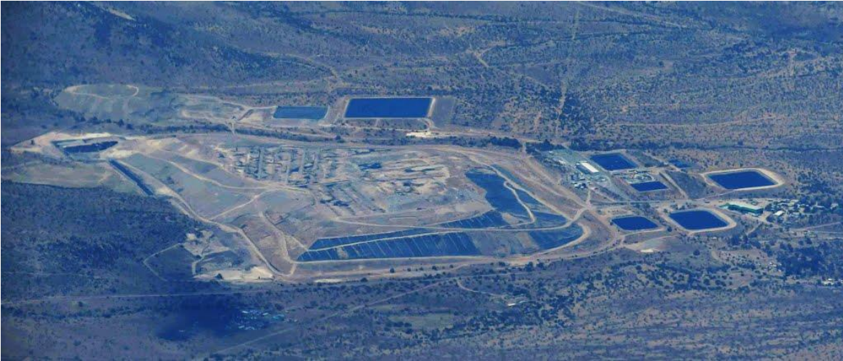
Figura 1: Relleno Sanitario Loma Los Colorados en Tiltit, Región Metropolitana
